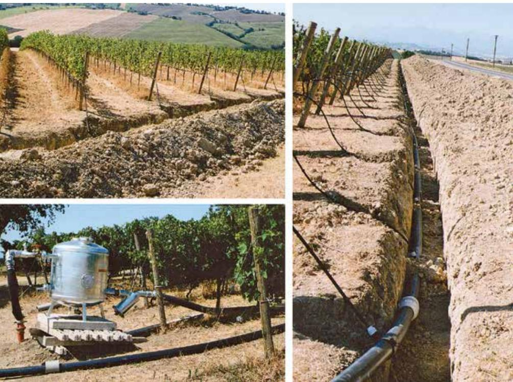
► Fig. 1. A partire da un punto di prelievo dotato spesso di pompa, serbatoio di accumulo e apparato filtrante, tramite una rete di tubazioni principali (spesso in buona parte interrata), l'acqua arriva alle ali gocciolanti complete di microerogatori, collocati in prossimità delle piante da irrigare
